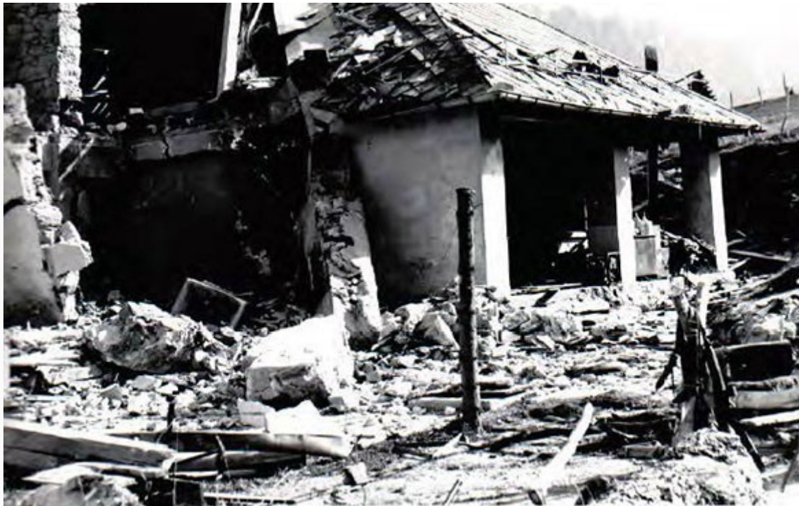
n°6-Particolare lato Ovest, zona dell'ufficio esploso.-
